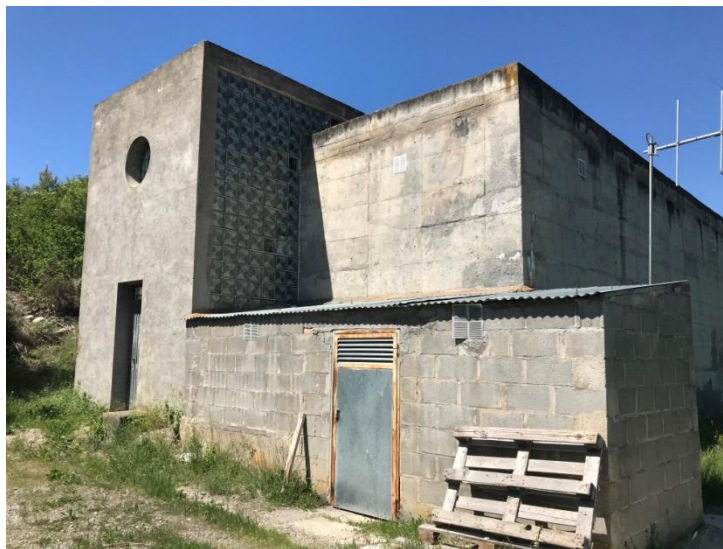
Fotografia 41. Vista general del dipòsit
