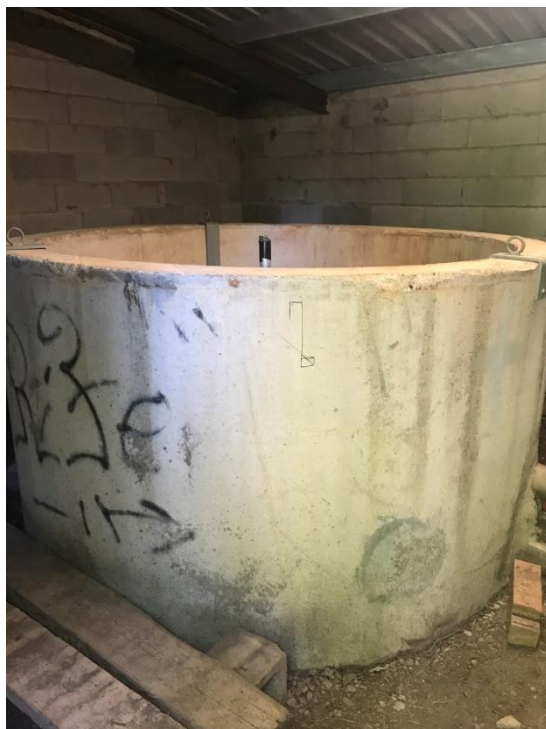
Fotografia 3. Entubació pou per evitar intrusions riu
