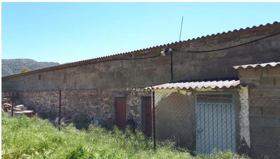
Fotografia 30. Vista exterior dipòsit
