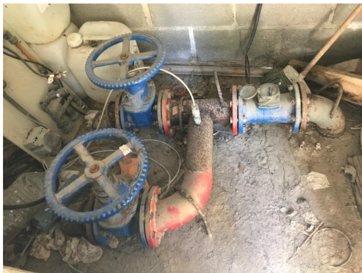
Fotografia 46. Caldereria sortida dipòsit i comptador
