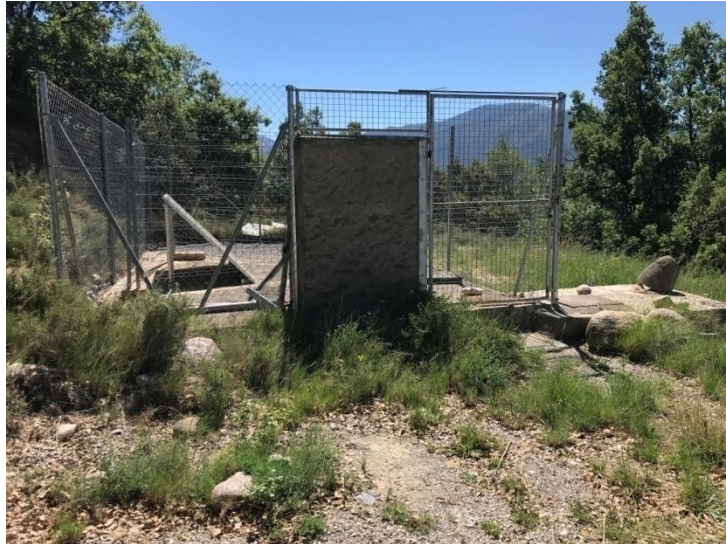
Fotografia 9. Vista general del dipòsit Sant Joan de Vinyafrescal
