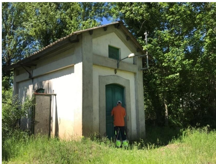
Fotografia 9. Caseta pou Bernadot. Caseta FECSA
