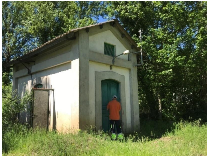
Fotografia 3. Caseta pou Bernadot. Caseta FECSA
