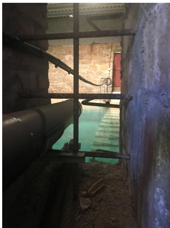
Fotografia 36. Vista interior dipòsit
