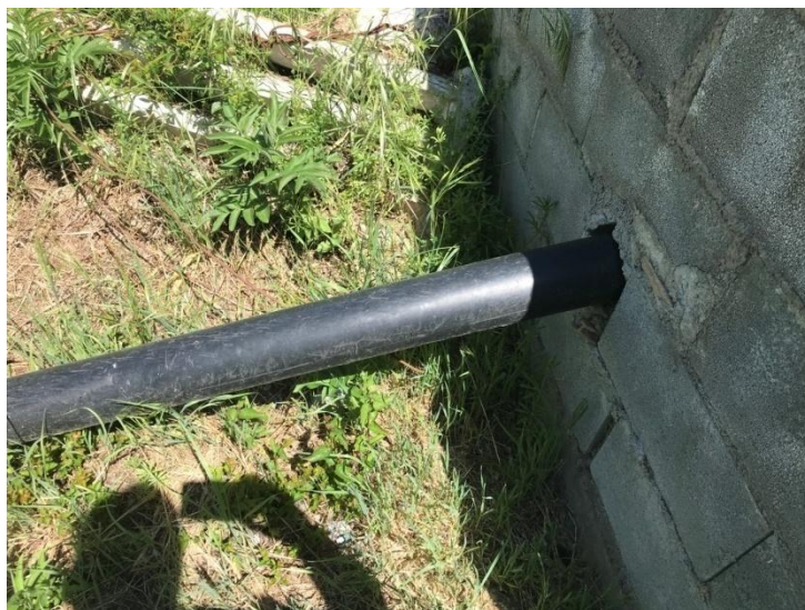
Fotografia 25. Conducció impulsió a sortida pou
