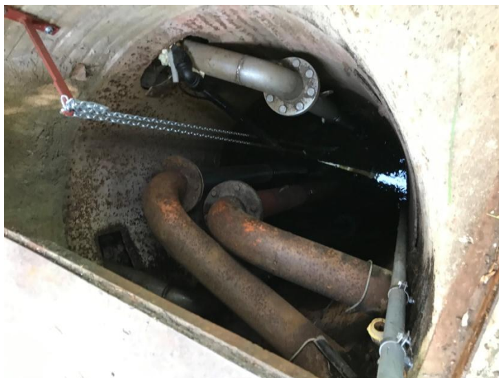
Fotografia 19. Entubació pou i conduccions aspiració
