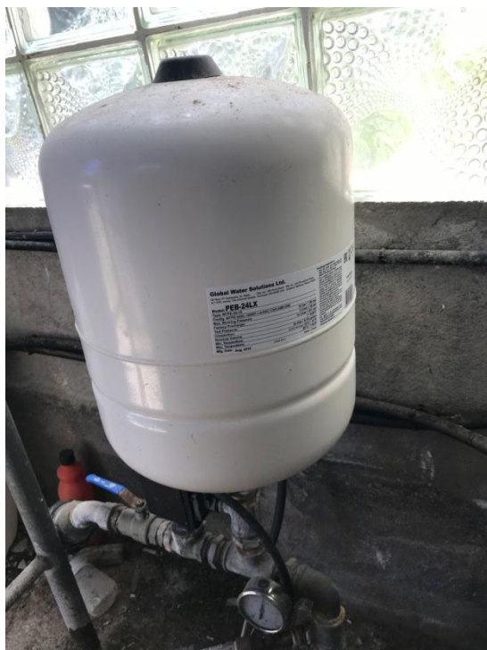
Fotografia 48. Calderí bombament
