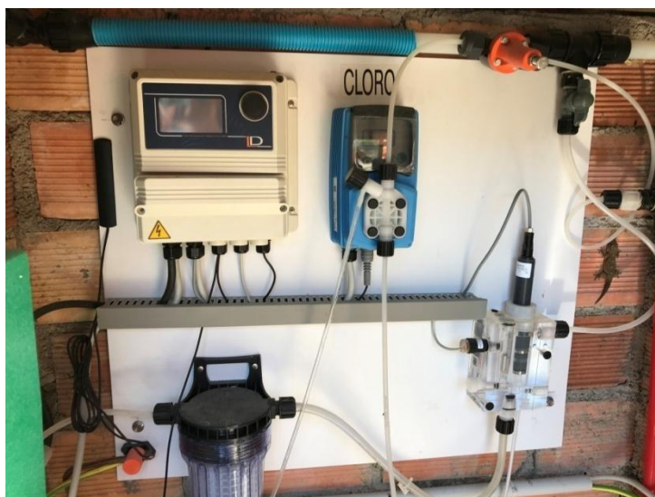
Fotografia 23. Equip dosificació automàtic de clor
