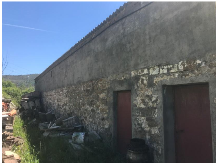
Fotografia 31. Vista exterior dipòsit
