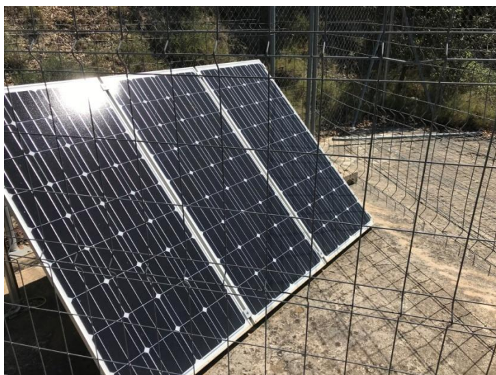
Fotografia 57. Plaques solars alimentació cloració
