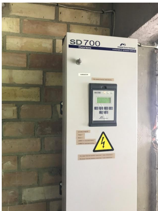
Fotografia 15. Variador freqüència
