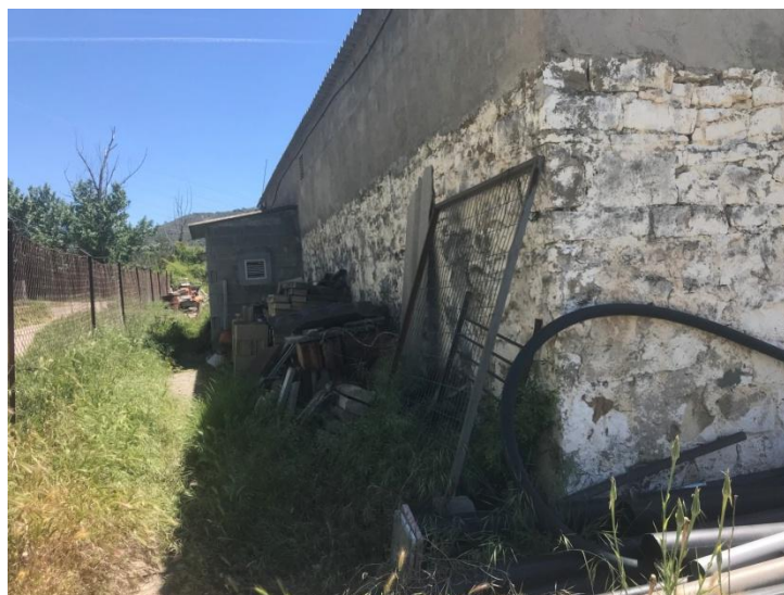
Fotografia 7. Vista exterior dipòsit Costapera
