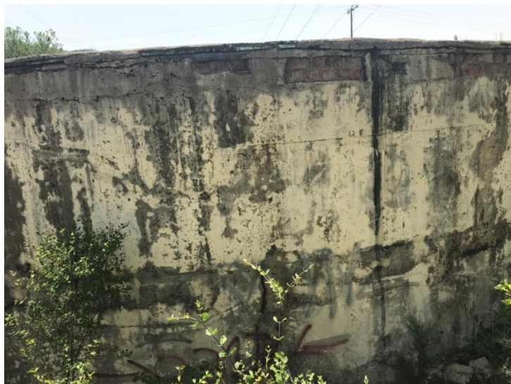
Fotografia 53. Vista general del dipòsit
