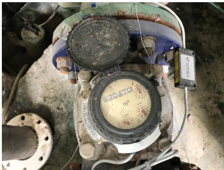
Fotografia 11. Comptador aigua a dipòsit
