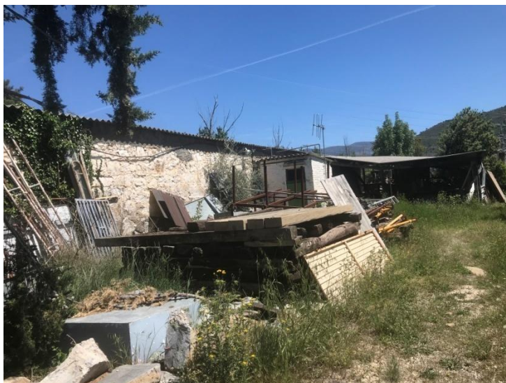
Fotografia 32. Vista exterior dipòsit
