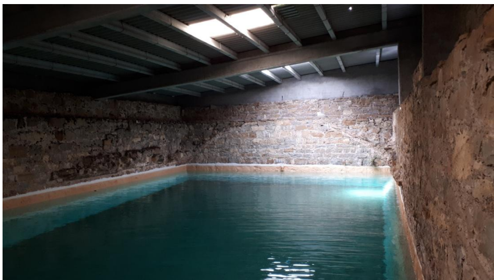
Fotografia 34. Vista interior dipòsit
