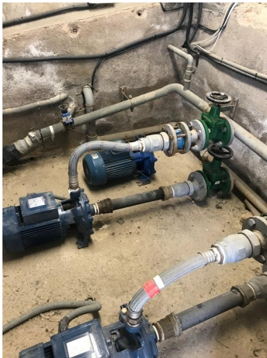
Fotografia 47. Grup de pressió Impulsió a xarxa
