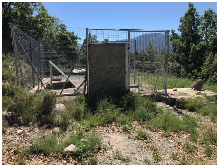
Fotografia 53. Vista general del dipòsit
