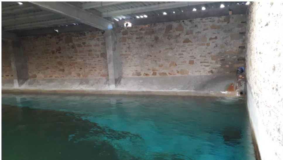
Fotografia 33. Vista interior dipòsit
