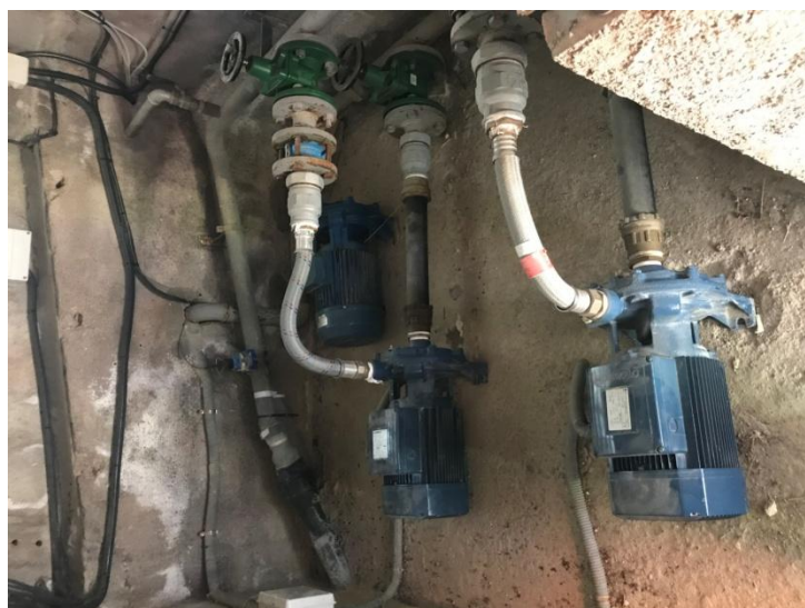
Fotografia 11. Grup de pressió Impulsió a xarxa
