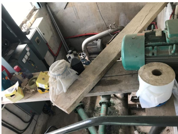
Fotografia 10. Interior caseta municipal
